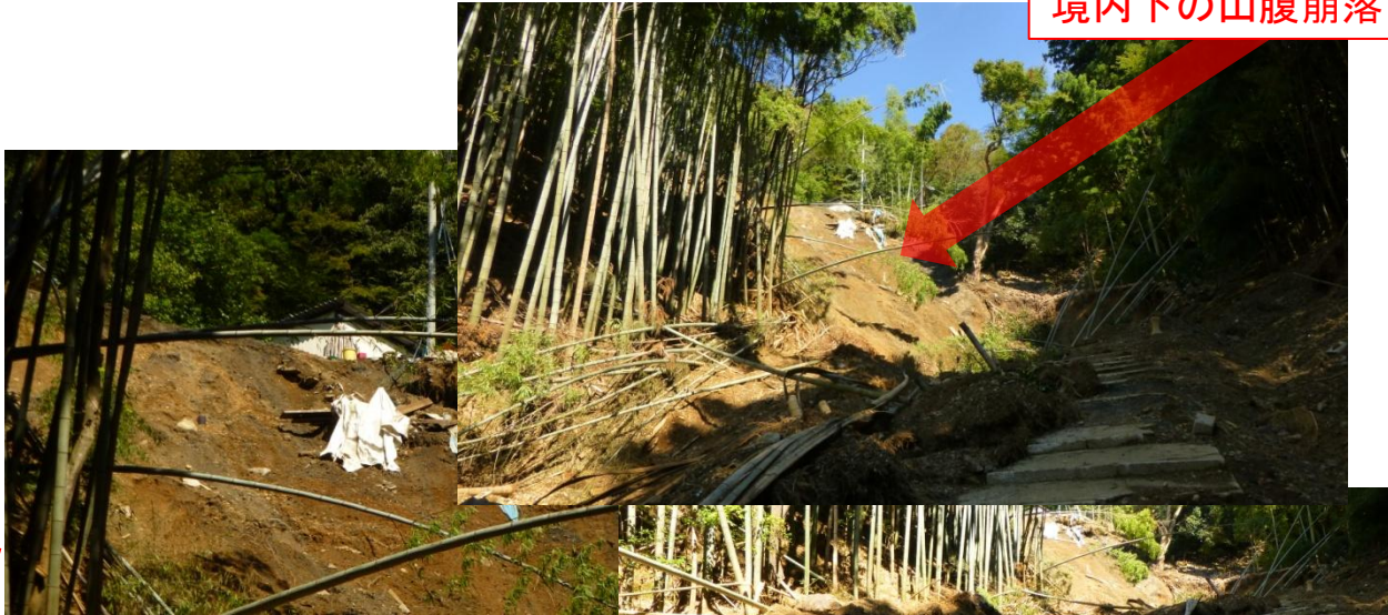
境内下の山腹崩落
